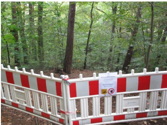
Dreizehn-Brücken-Weg gesperrt Bauarbeiten vom Hochwasser- schadenbeseitigung und Brücken- abriss und-neubau bis zum 2.12.2016
